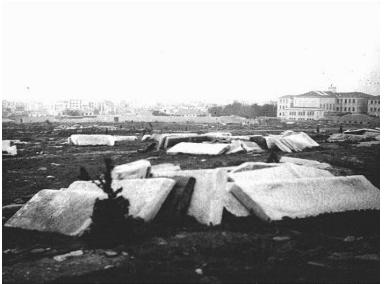
Άποψη του κατεστραμμένου εβραϊκού νεκροταφείου στην κατεχόμενη Θεσσαλονίκη (1942). Οι ταφόπλακες θα χρησιμοποιηθούν ως οικοδομικά υλικά.
